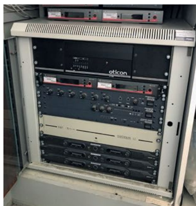
Her er et typisk lyd-anlæg i en kirke. Ofte er der et stik bag på teleslyngeforstærkeren (øverst), hvorfra man kan trække en ledning ud i det fri, så man kan sende lyden fra kirken herud til et par højttalere
